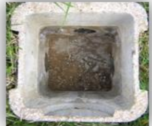
Photo regard de bouclage en béton, à trois arrivées, totalement sec.
