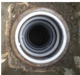
Le regard de collecte se reconnaît par sa forte profondeur
