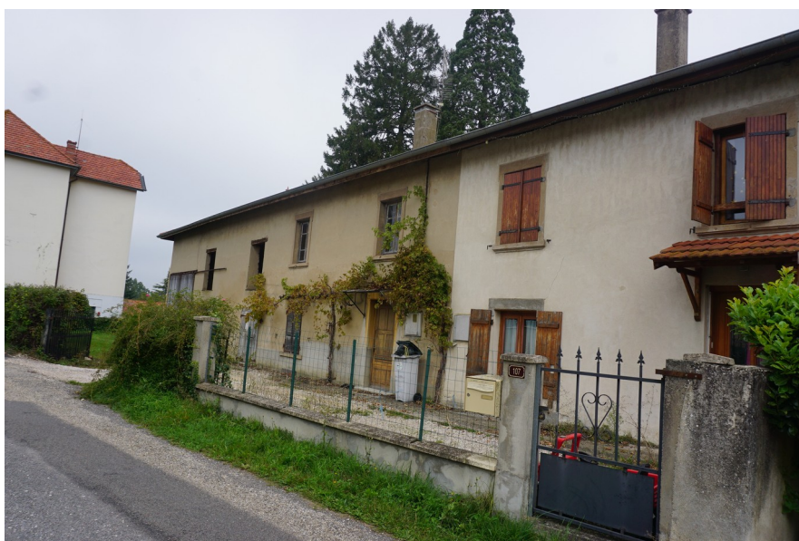
Chaveyriat, bâtiment d'accompagnement (source: UDAP Ain)
