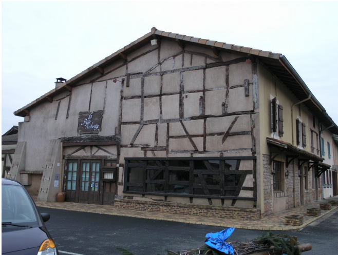
Saint-Jean sur Veyle, maison à pans de bois, 2016 (source : UDAP de l'Ain)
