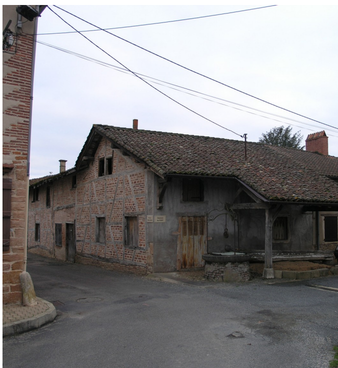
Saint-Jean sur Veyle, abords immédiats, maison à pans de bois, 2016 (source : UDAP de l'Ain)
