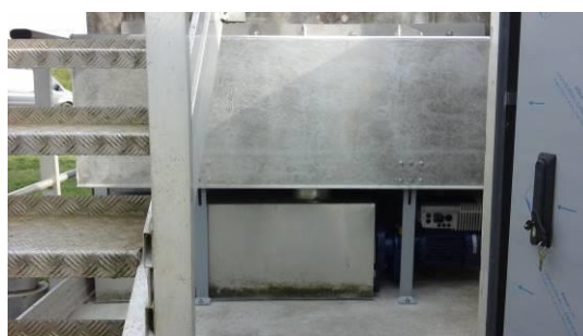
Photos de la nouvelle pompe à flottant installée avec création d'un caisson de calorifugeage.
