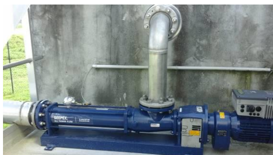
Photos de la nouvelle pompe à flottant installée avec création d'un caisson de calorifugeage.
