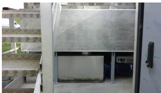
Protection antigel pompe à flottant et mise en place d'un « capotage »
