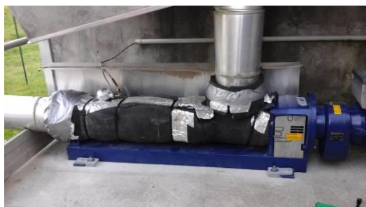
Protection antigel pompe à flottant et mise en place d'un « capotage »
