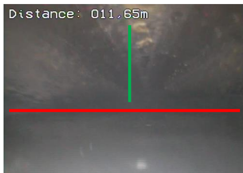
Niveau d'eau permanent
